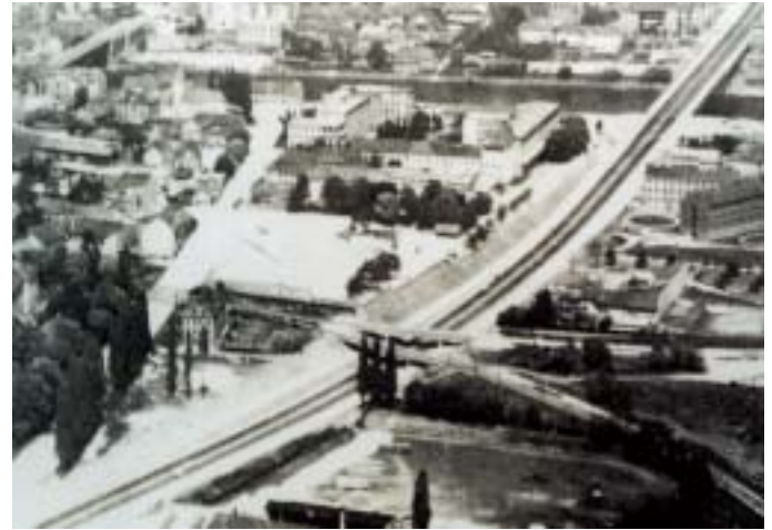
Parcela na južni strani bolnišnice, pripravljena za začetek gradnje stolpnice.
