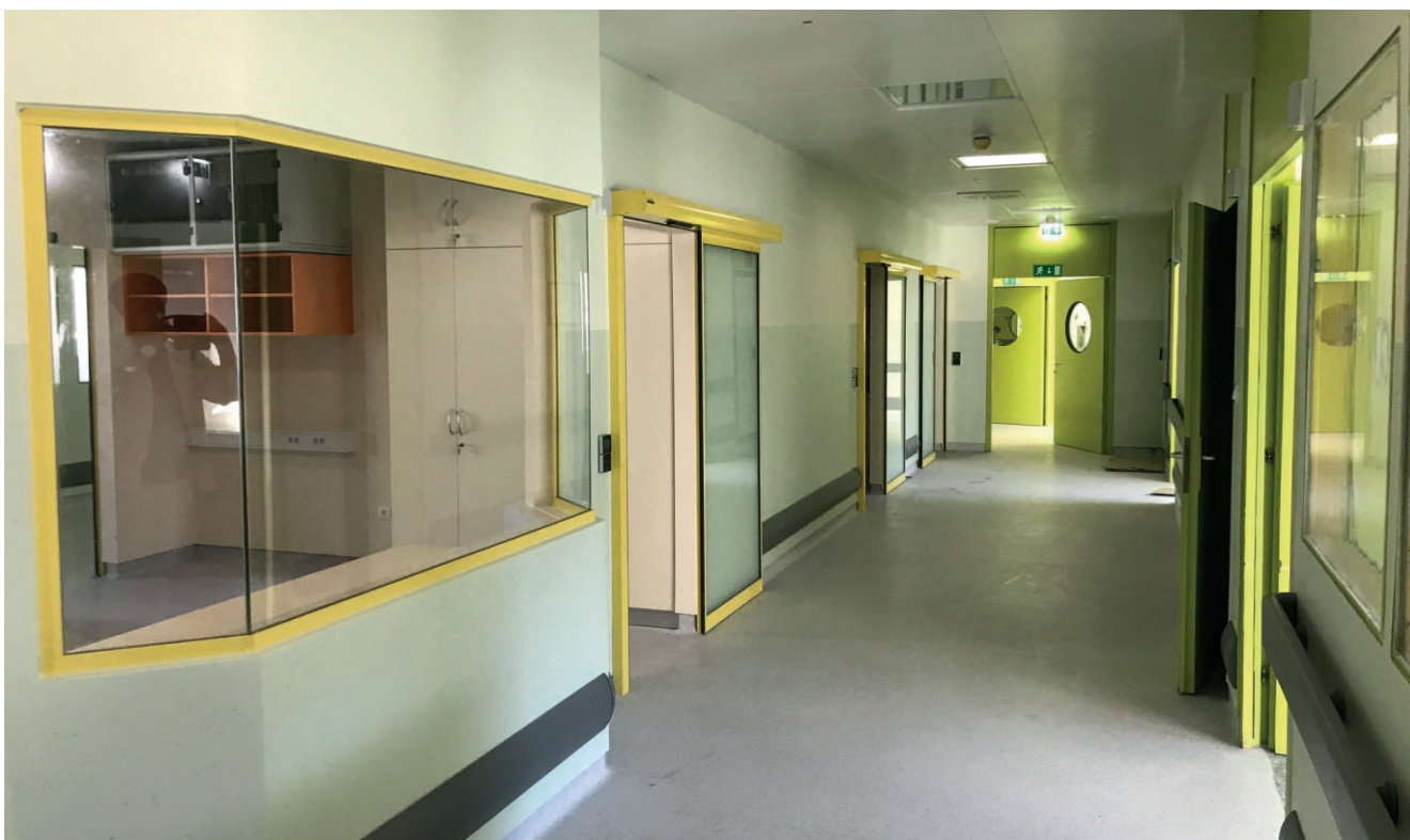
Slika 3: Novi prostori EINT Klinike za pediatrijo tik pred zaključkom obnovitvenih del (lasten vir).
