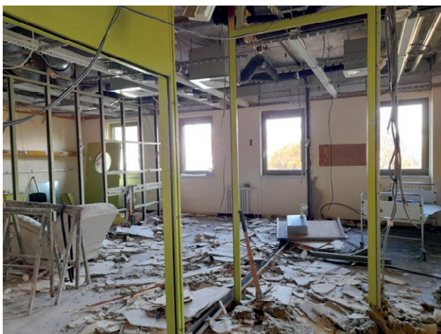
Slika 2: Začetek obnove EINT Klinike za pediatrijo (lasten vir).
