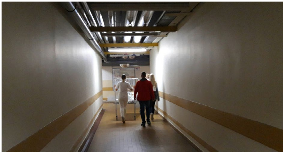
Podzemni hodnik pod Oddelkom za pediatrijo pred začetkom projekta, Jarh L, 2019
